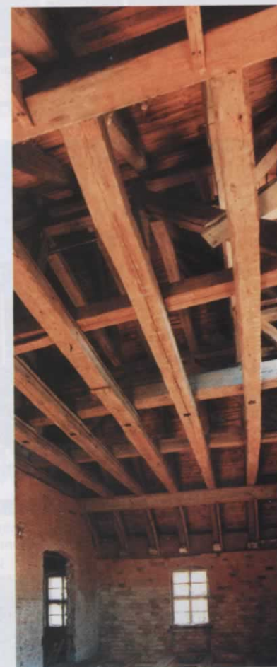
W przeszłości cieśle budując więźby dachowe kierowali się głównie intuicją – w efekcie powstawały konstrukcje w dużej mierze przewymiarowane.
