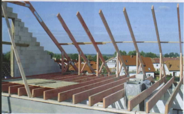
Elementy drewniane w węzłach łączone są stalowymi, ocynkowanymi płytkami kolczastymi pneumatycznie wciskany w drewno.
