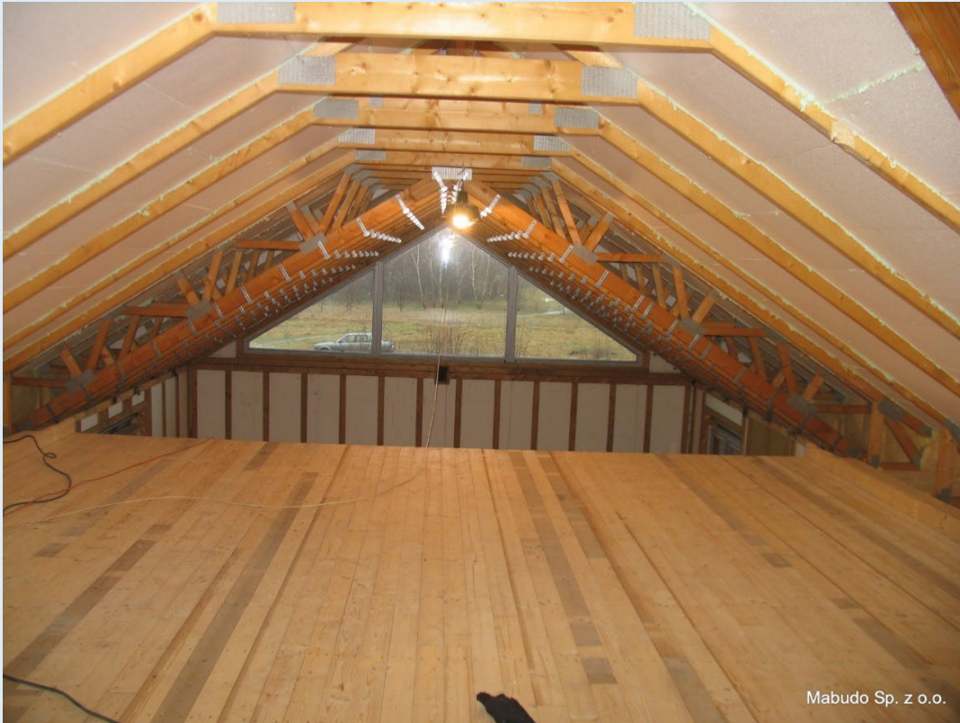
Wiązary nożycowe z oknem w ścianie szczytowej o równoległych pasach sufitu i dachu (widok od strony otwartej antresoli)
