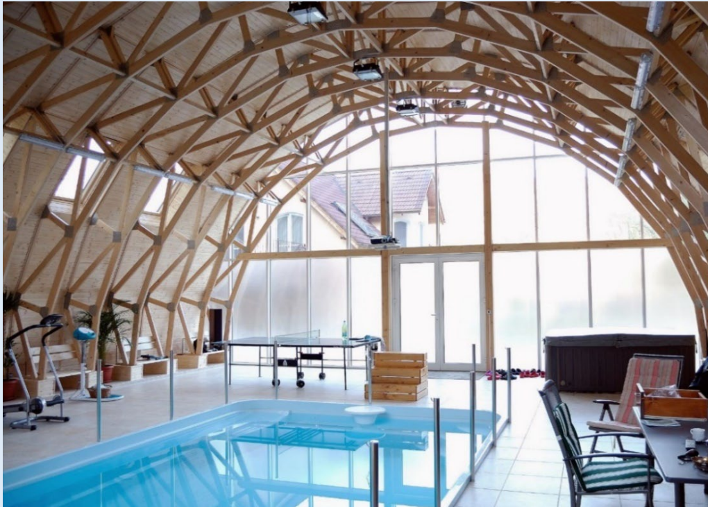
Wiązary z sufitem łukowym w obiekcie hotelowym
