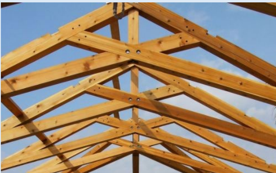
Wiązar nożycowy z podniesionym pasem dolnym łączonym węzłem ciesielskim
