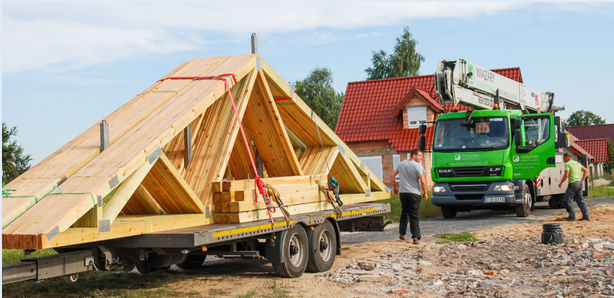
Dostawa prefabrykowanej więźby wiązarowej
