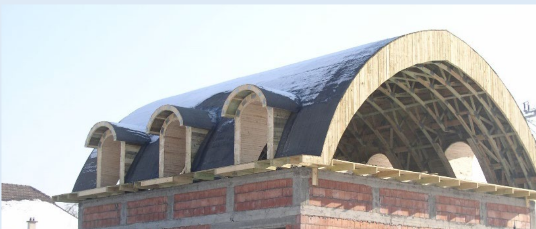
Montaż i wygląd zmontowanej konstrukcji wiązarowej wraz z pokryciem dla budynku wielorodzinnego (BURKIETOWICZ)
