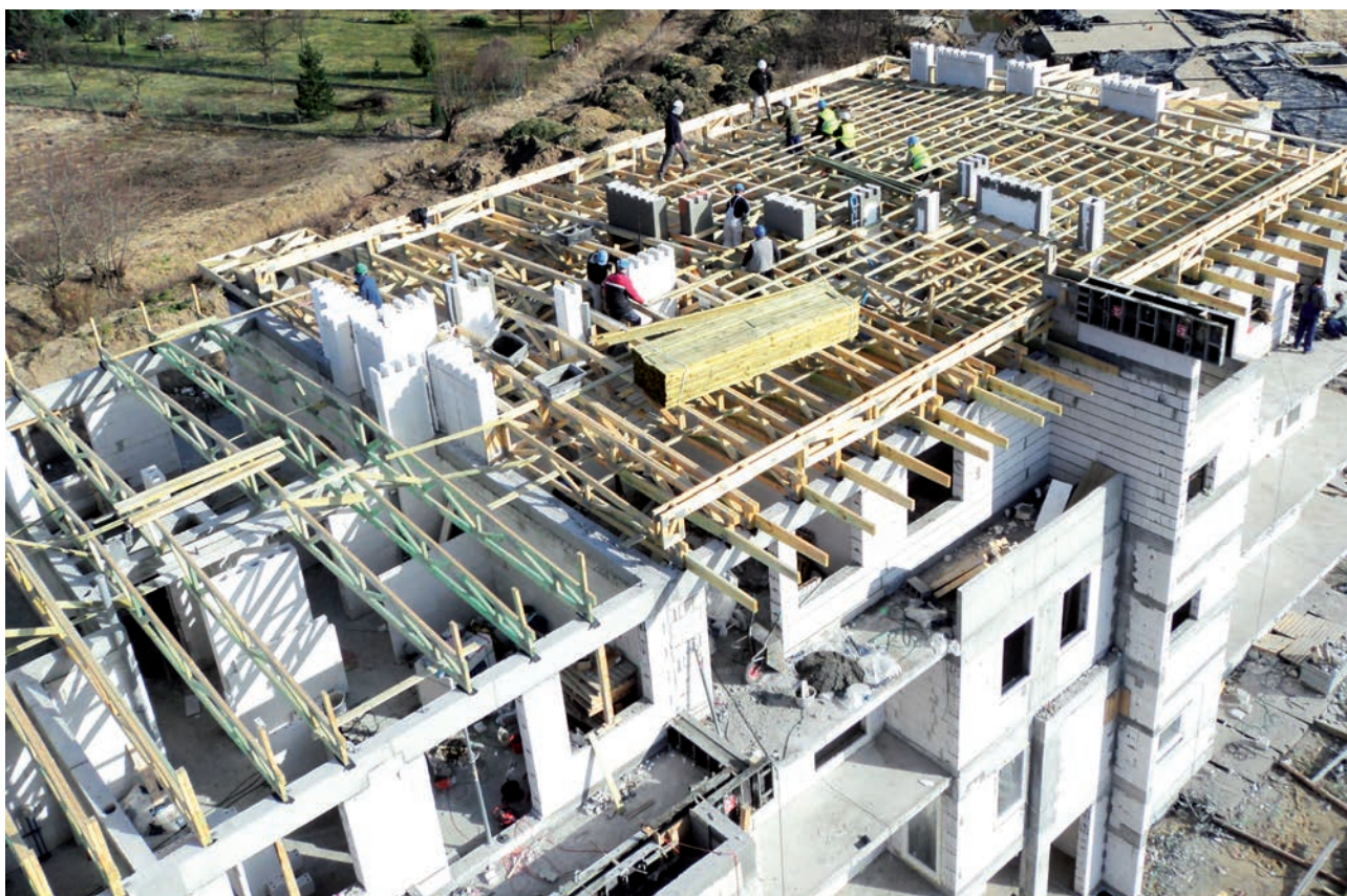
Więzarowa konstrukcja stropodachowa na budynku wielopiętrowym (realizacja WIĄZARY BURKIETOWICZ)
