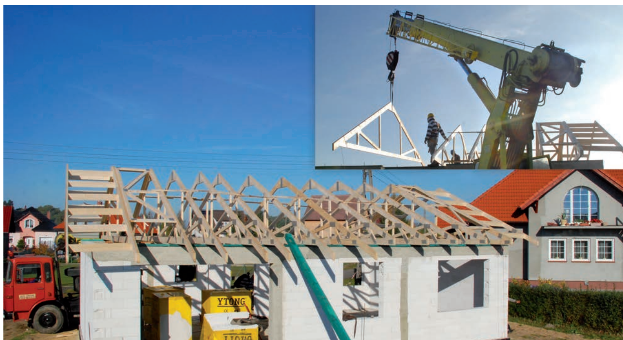
Dzięki zastosowaniu wiązarów w domu o powierzchni 82m 2 uzyskano strych 26m 2 (realizacja WEST-MALL)
