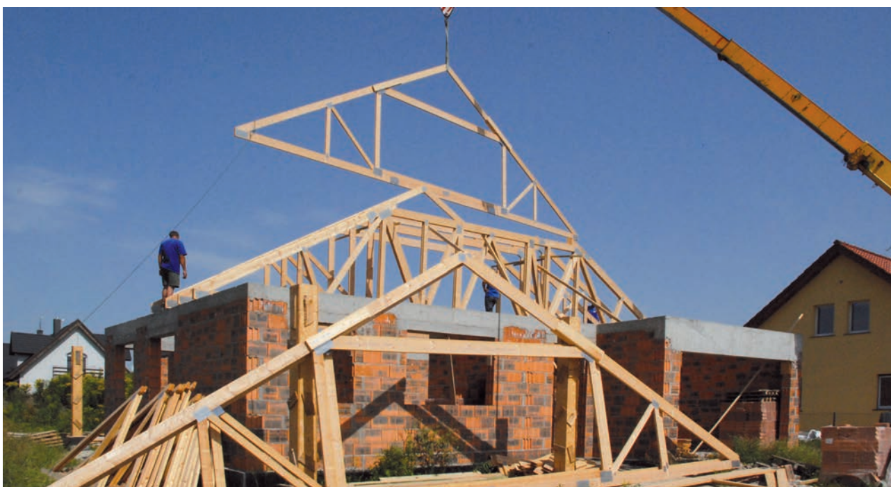
Montaż wiązarów – przestrzeń na strych na poddaszu (realizacja WIĄZARY LEWANDOWSKI)
