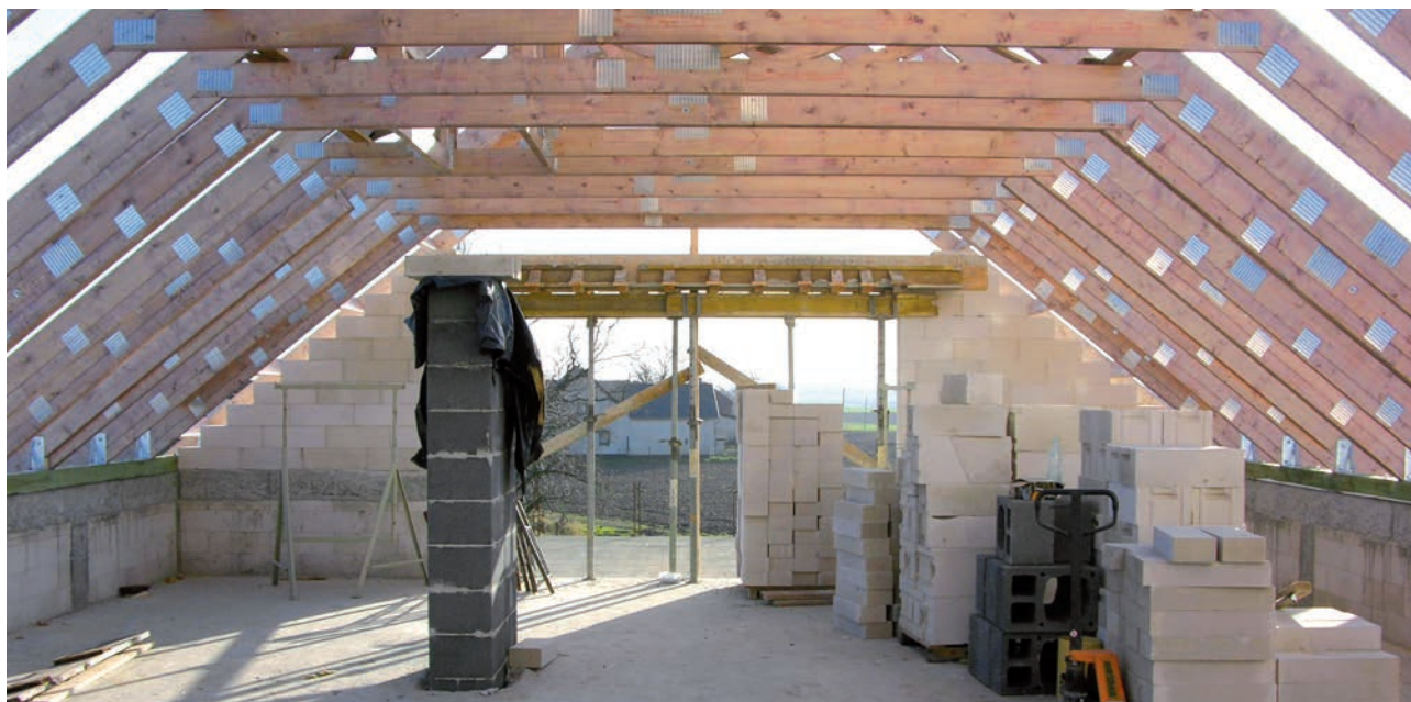
Wiązary na stropie betonowym - swoboda ustawiania ścian działowych (realizacja WIĄZAR-SYSTEM)
