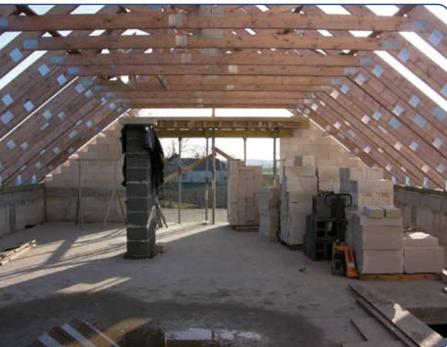
Wiązary na stropie betonowym – swoboda ustawiania ścian działowych (realizacja WIĄZAR-SYSTEM).
