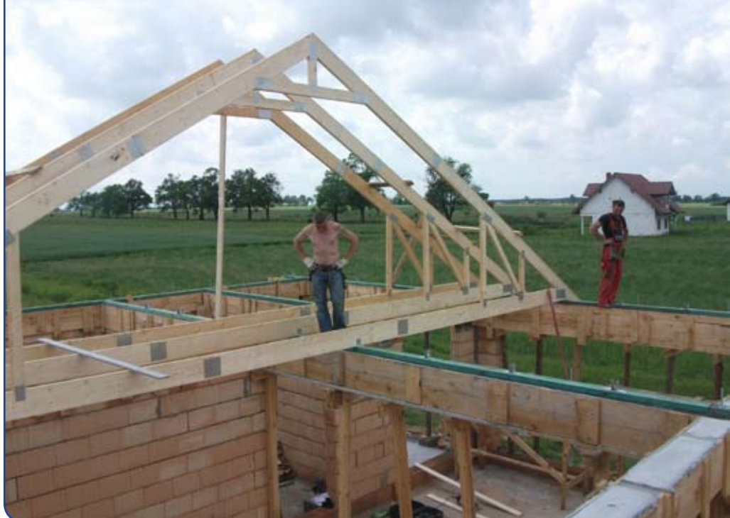
Pas dolny wiązara będzie stanowić konstrukcję stropu (realizacja WEST-MALL)
