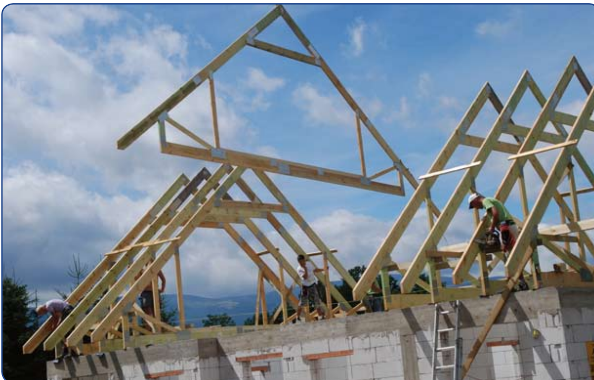
Montaż domu według projektu „Z7”, ze zmienionym kątem nachylenia dachu na 40 stopni – dzięki wiązarom uzyskano duże, przestrzenne poddasze (realizacja WIĄZARY BURKIETOWICZ).
